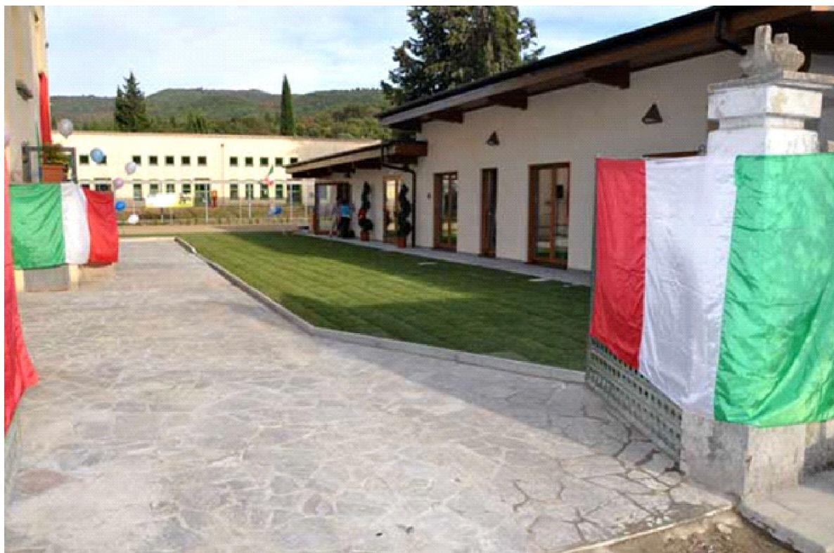
Nuova struttura in bioedilizia
